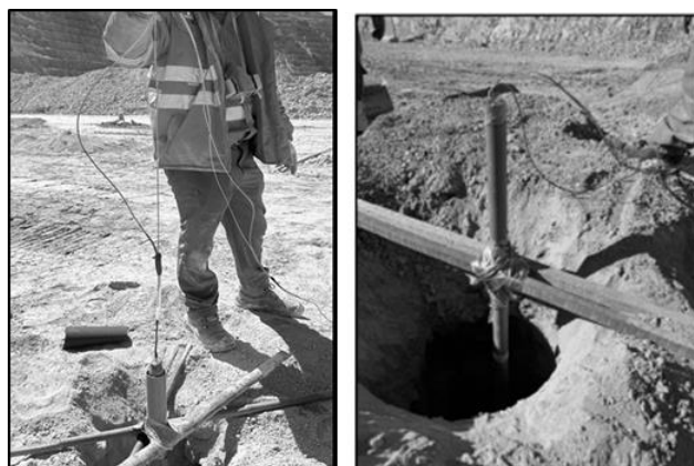
Figura 7: Proceso de instalación de los sensores de presión
